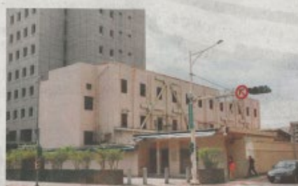
元大人壽標下AIT舊址地上權
